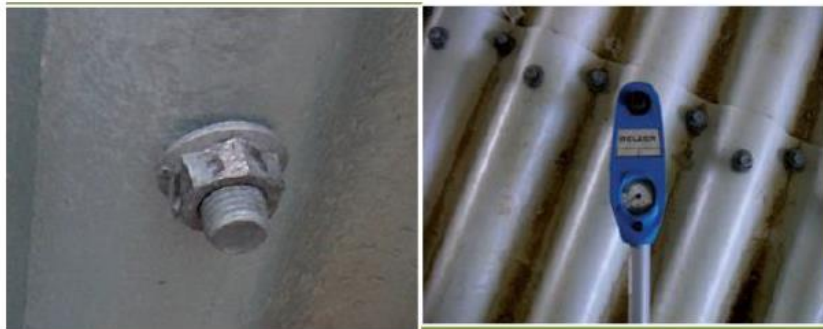
Слика 6 Монтажа завртња
