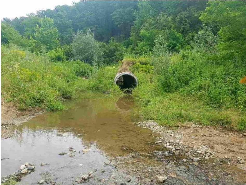
Слика 1. Постојећи пропуст након поплава 2016. Године
