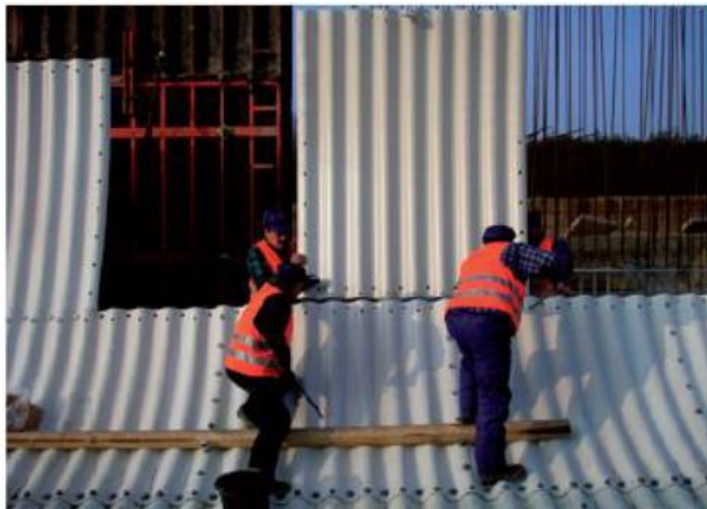
Слика 4. Монтажа елемената челичне конструкције
