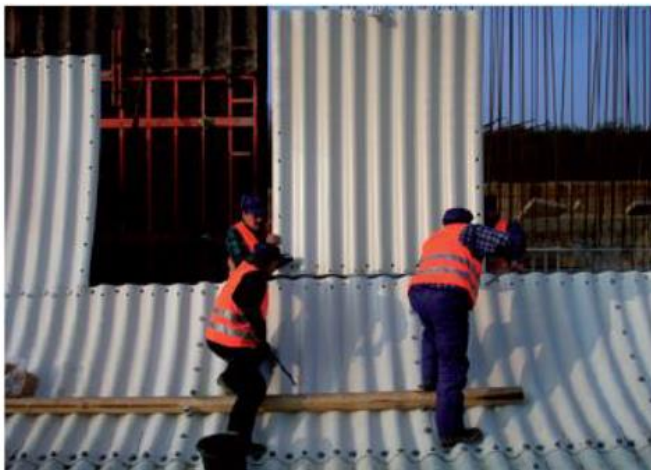
Слика 4. Монтажа елемената челичне конструкције
