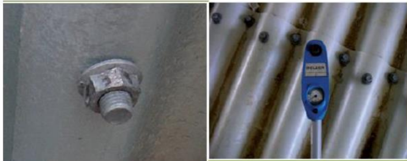
Слика 6 Монтажа завртња
